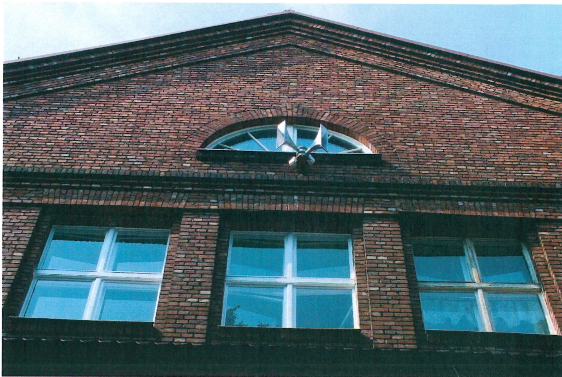
Syrena elektroniczna znajdująca się na budynku szkoły podstawowej nr 2.
