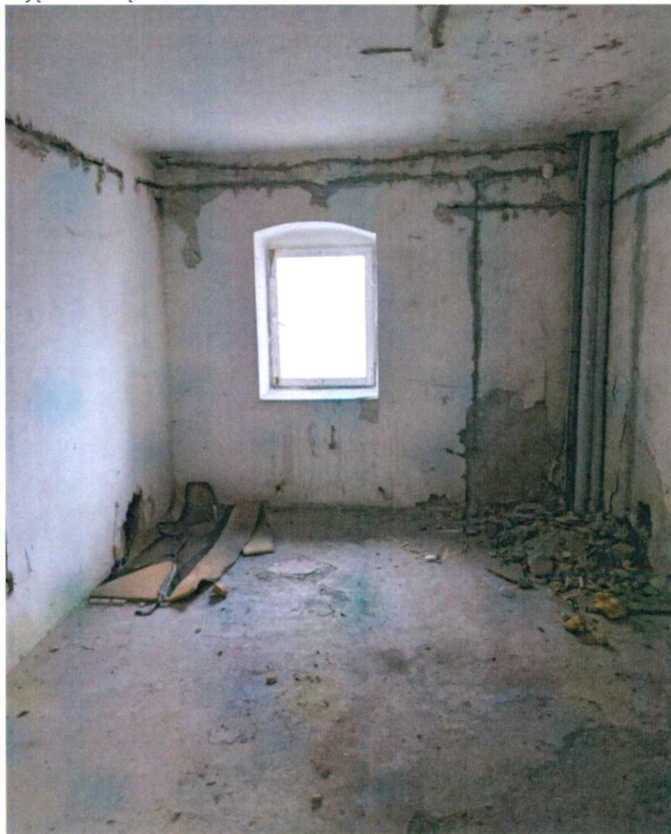
Zdjęcie 7 Wnętrze Pałacu Potulickich.
